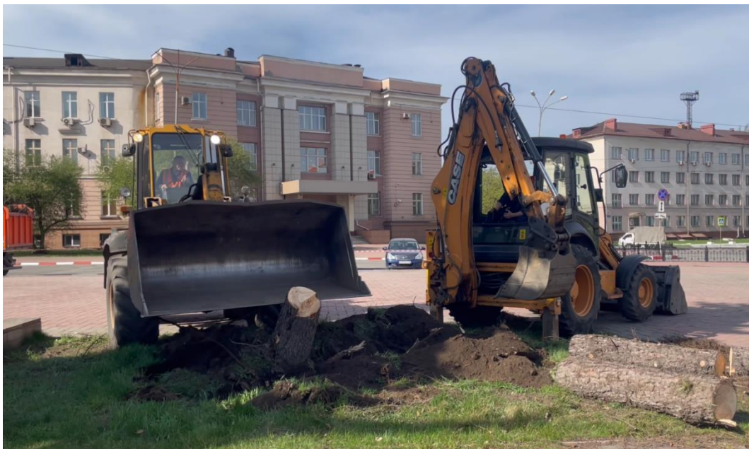
Рис. 2.11. Корчевка пней при помощи бульдозера и экскаватора
