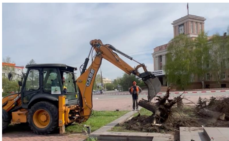
Рис. 2.10. Корчевка пней при помощи экскаватора
